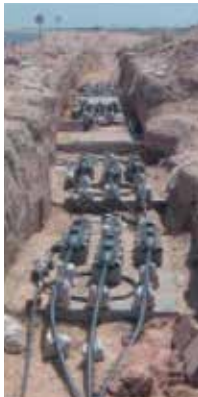
送電線ケーブル工事
