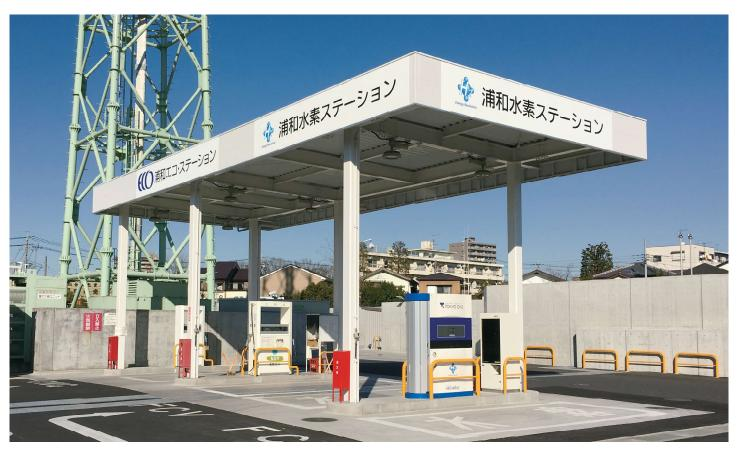
浦和水素ステーションは、水素をその場で製造し、供給するオンサイト型の水素ステーションで、出荷機能を担う東京ガスの中核的な水素ステーションです。浦和水素ステーションでつくられた水素は、燃料電池自動車への充填に加えて、練馬水素ステーション等へ出荷します。パイプライン網で送られた都市ガスを改質して水素を作っているため、外部から水素を運び込む必要がなく、供給安定性に優れています。
